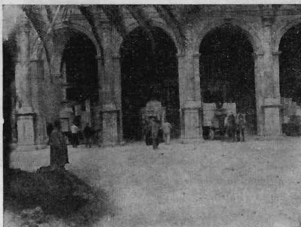
A Roma -- Nel giardino di Palazzo Venezia In attesa dello scarico
