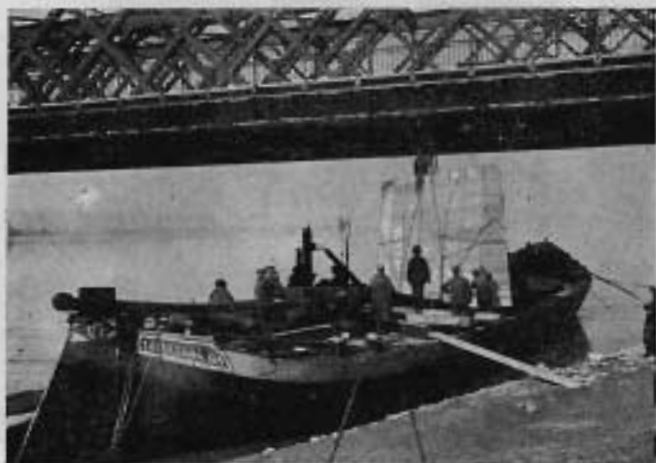
La manovra di scarico sotto il ponte di ferro a Cremona
