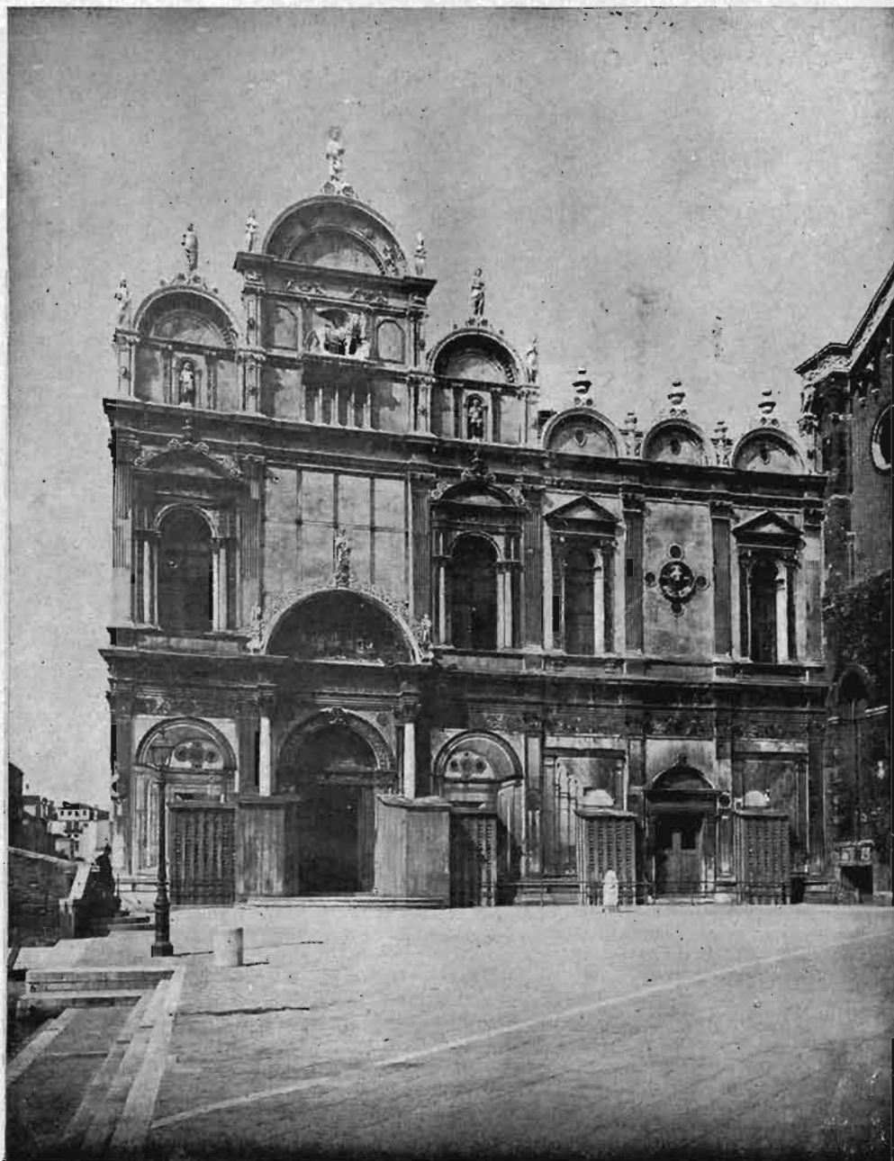
Venezia, Ospedale Civile già Scuola Grande di S. Marco — Protezione alla facciata.
