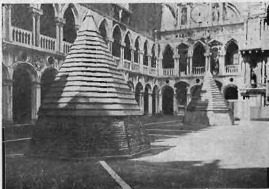
Venezia, Palazzo Ducale. Protezione dei pozzali nel cortile.
