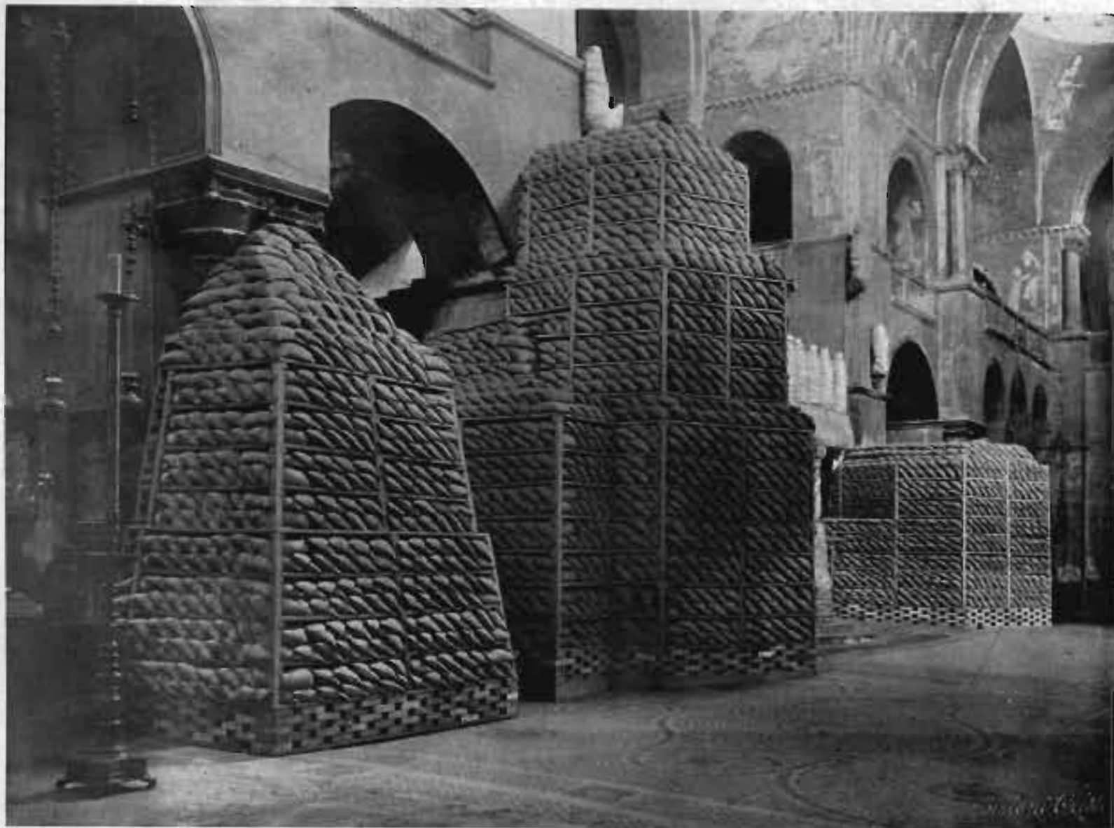
Venezia, S. Marco — Protezione dei due amboni e dell'altare di S. Paolo.
