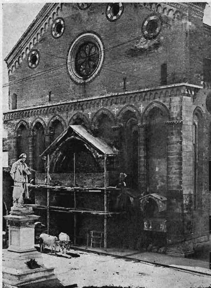
Vicenza, S. Lorenzo — Lavori di protezione al portale.
