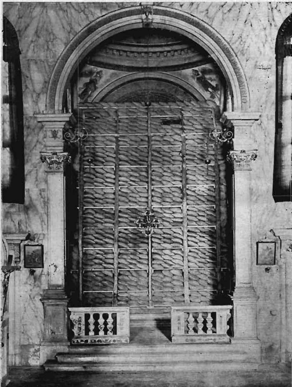
Venezia, Chiesa di S. Trovaso — Protezione dell'altare del Sacramento.
