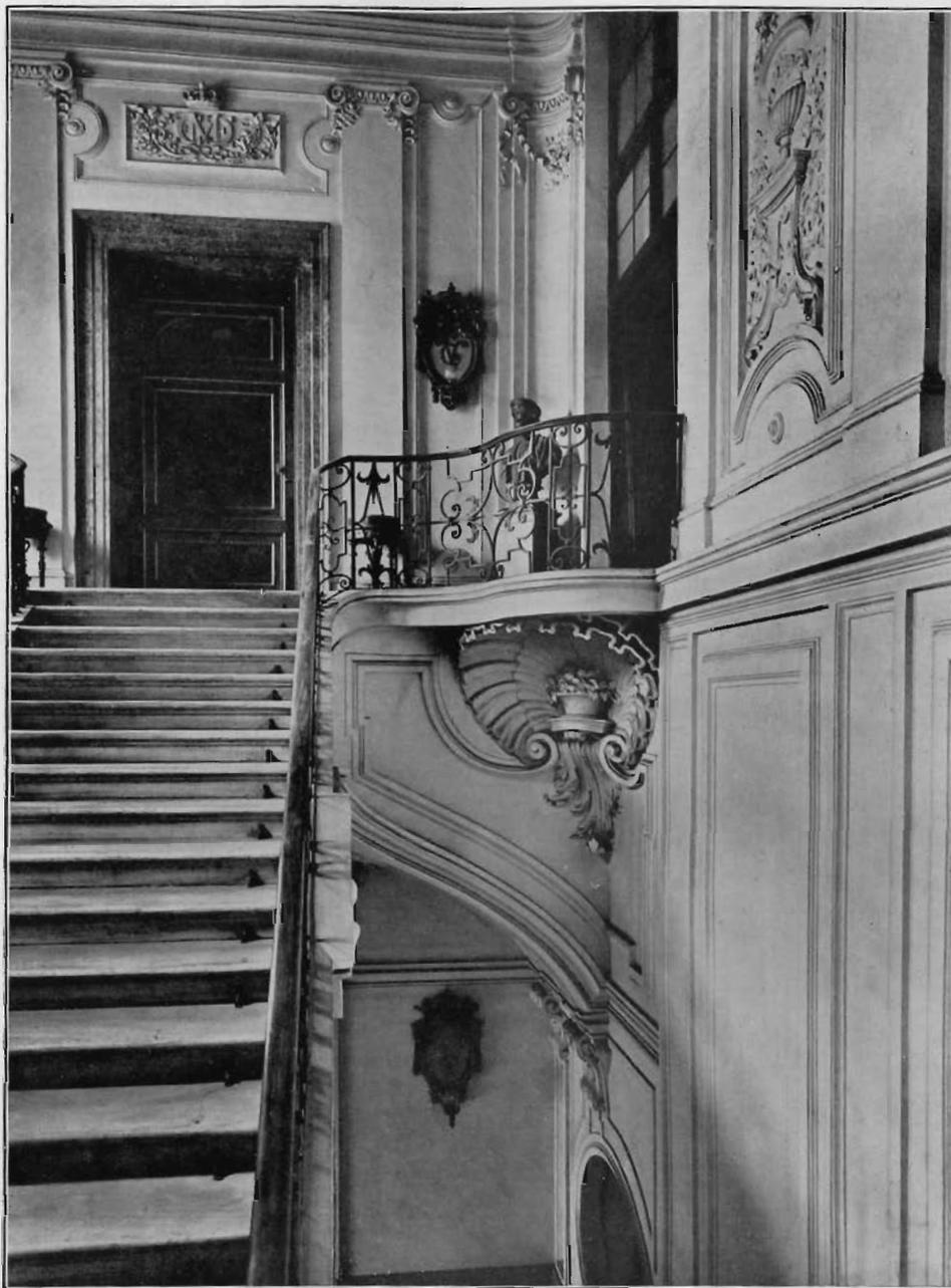
Fig. 7. — Filippo Juvara - Particolare (una delle mensole che sorreggono l'ultimo pianerottolo) della scala delle « forbici » Torino, Palazzo Reale (fol. Pedrini).
