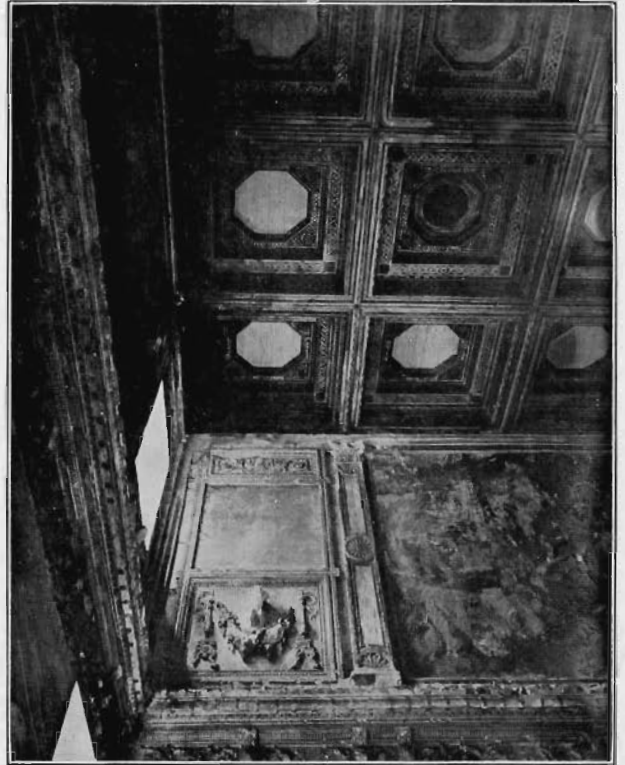
Fig. 2. — Sala grande. Soffitto ed angolo nord-est. (Prima del restauro).
