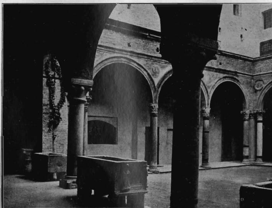
Fig. 8. — Cortile, Loggiato. Lato di levante, dopo il restauro.
