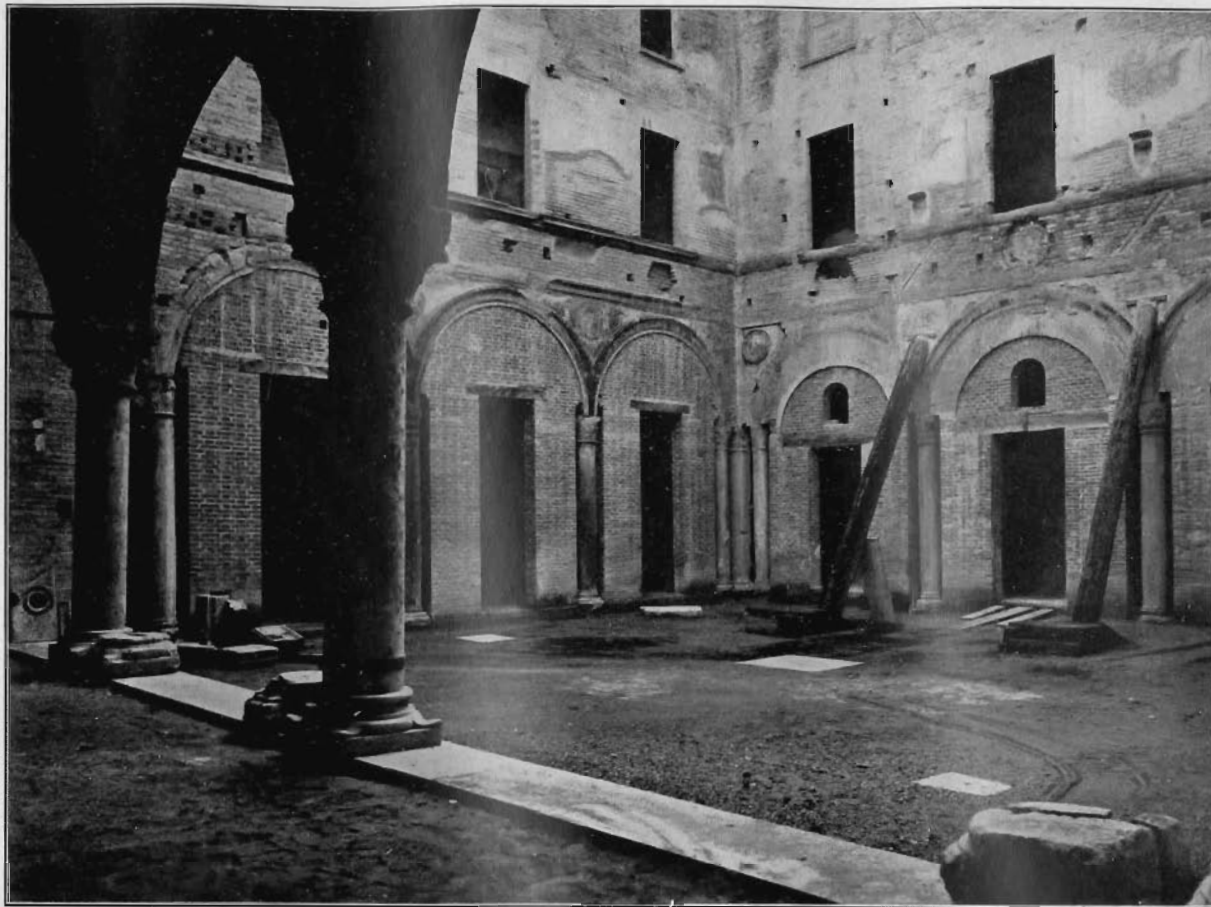
Fig. 5. — Cortile, loggiato. Prima del restauro (1926).
