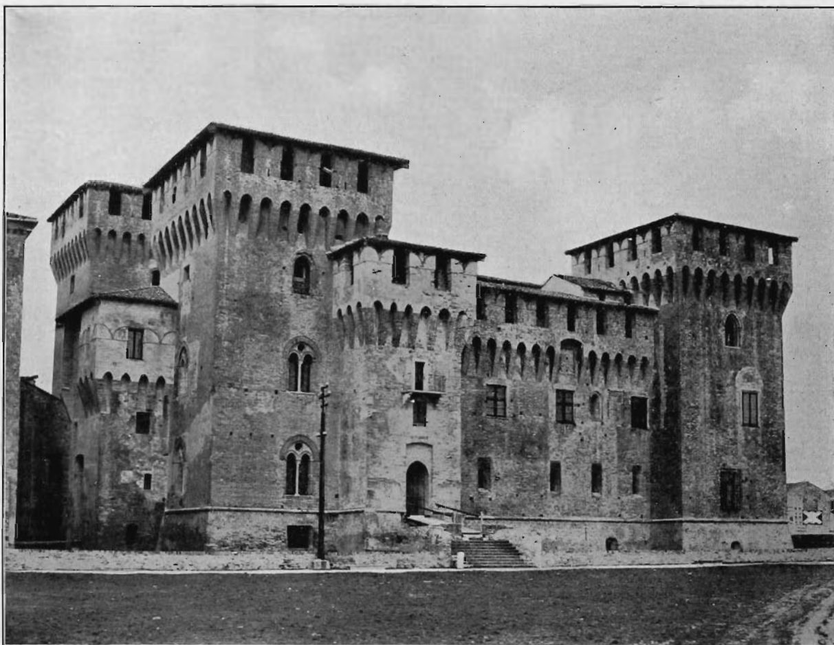
Fig. 9. — Castello, Facciata esterna di levante. Dopo i restauri (1923-1928).
