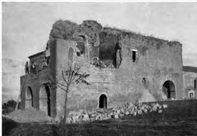
VENOSA, LA FORESTERIA PRESSO LA TRINITÀ: INIZIO DEI LAVORI DI CONSOLIDAMENTO E RESTAURO (Fot. E. Palmieri)
