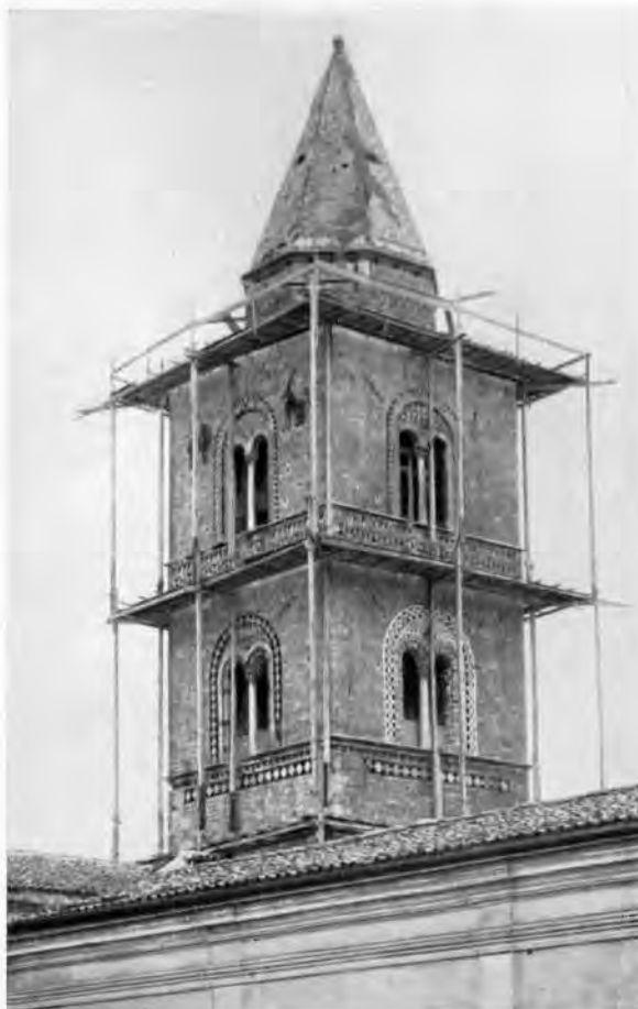
MELFI: IL CAMPANILE NORMANNO DELLA CATTEDRALE DURANTE LE OPERE DI CONSOLIDAMENTO (SI DISTINGUONO NITIDAMENTE LE DECORAZIONI BICROME INTORNO ALLE FINESTRE) (Fot. prof. Rubino)
