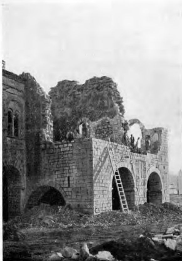
VENOSA, LA FORESTERIA PRESSO LA TRINITÀ: INIZIO DEI LAVORI DI CONSOLIDAMENTO E RESTAURO (Fot. E. Palmieri)
