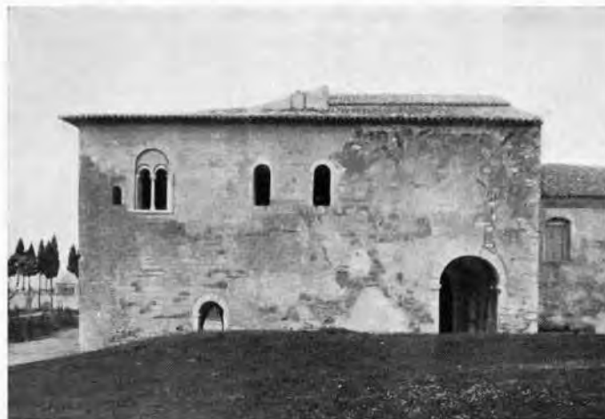
VENOSA: LATO DELLA FORESTERIA, PRESSO LA TRINITÀ, RIVOLTO ALL'ABITATO, DOPO IL RESTAURO (Fot. E. Palmieri)
