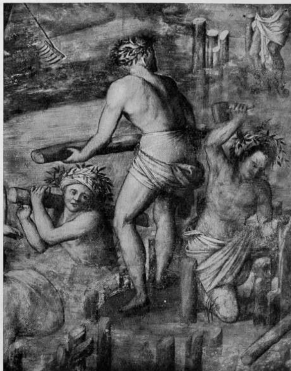
FIG. 8 - LUCCA, CHIESA DI S. FREDIANO - AMICO ASPERTINI: OPERAI (PARTICOLARE DELL'AFFRESCO RAPPRESENTANTE "S. FREDIANO CHE DIRIGE I LAVORI PER LA DEVIAZIONE DEL SERCHIO" (Fot. Soprint., Firenze)
