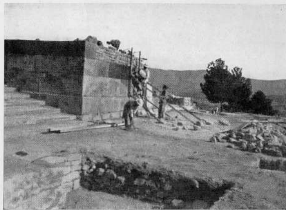
FIG. 6 - RESTAURO E RIFACIMENTO DI BLOCCHI
