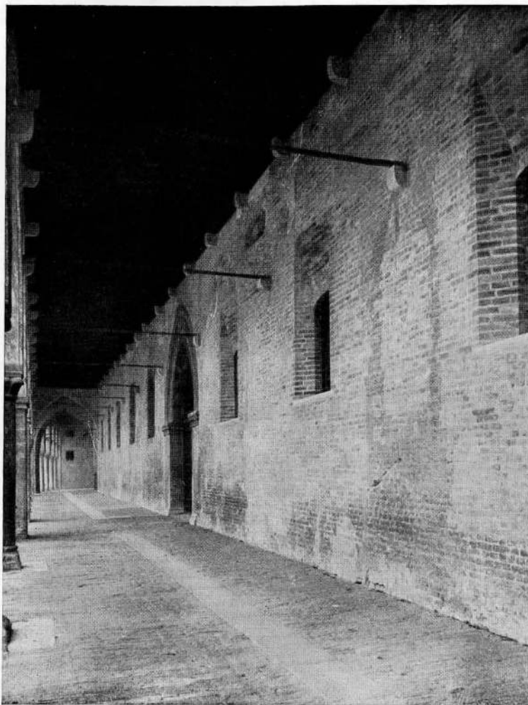
FIG. 2 - MANTOVA, PALAZZO DUCALE - PORTICO DEL PALAZZO DEL CAPITANO DOPO IL RESTAURO
