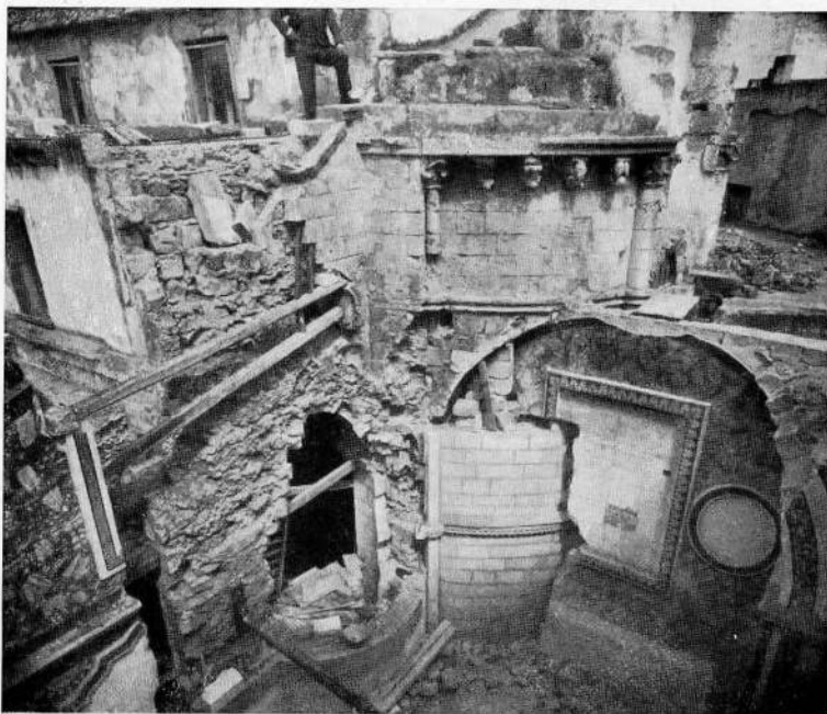
FIG. 5 - MONOPOLI, S. MARIA DEGLI AMALFITANI - LO STATO DEI LAVORI NELLA ZONA ABSIDALE DOPO L'ABBATTIMENTO DELL'ORATORIO
