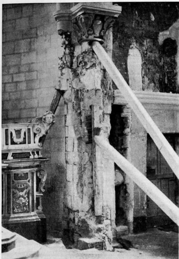
FIG. 3 - MONOPOLI, S. M. DEGLI AMALFITANI PILASTRO INTERNO DELL'ABSIDE DURANTE I RESTAURI
