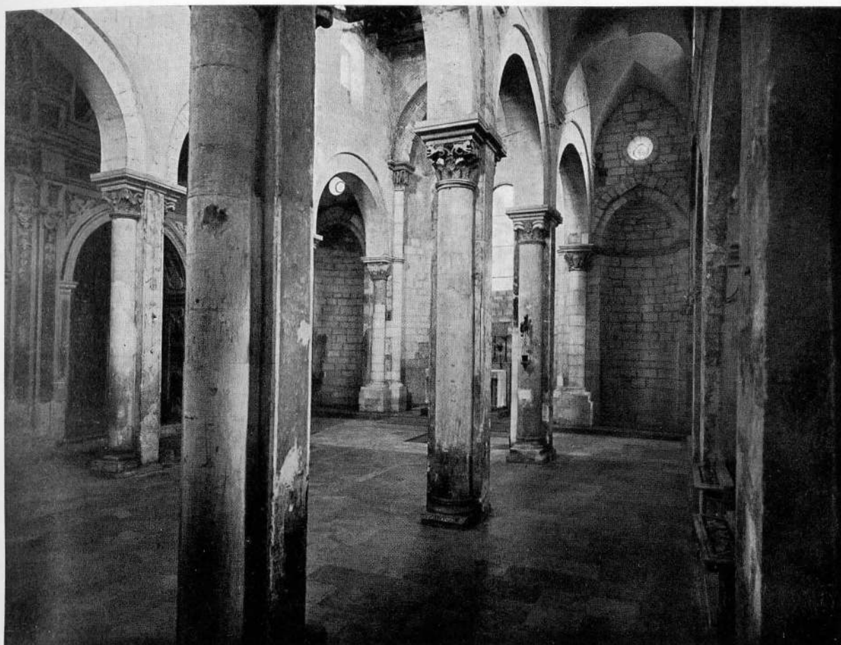
FIG. 16 - MONOPOLI, S. MARIA DEGLI AMALFITANI - INTERNO DOPO IL RESTAURO
