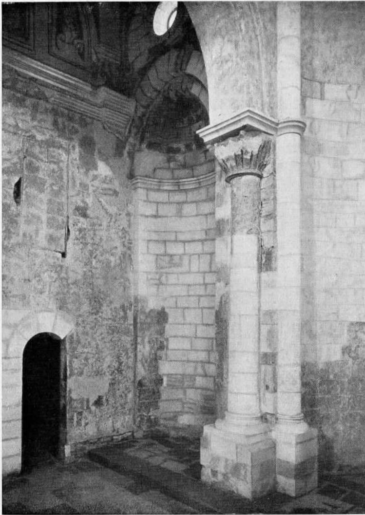
FIG. 15 - MONOPOLI, S. MARIA DEGLI AMALFITANI PARTICOLARE DELL'INTERNO DELLE ABSIDI RESTAURATE
