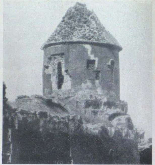
BAGNAIR, CHIESA DELLA MATER LUMINIS (DAL RIVOIRA)
