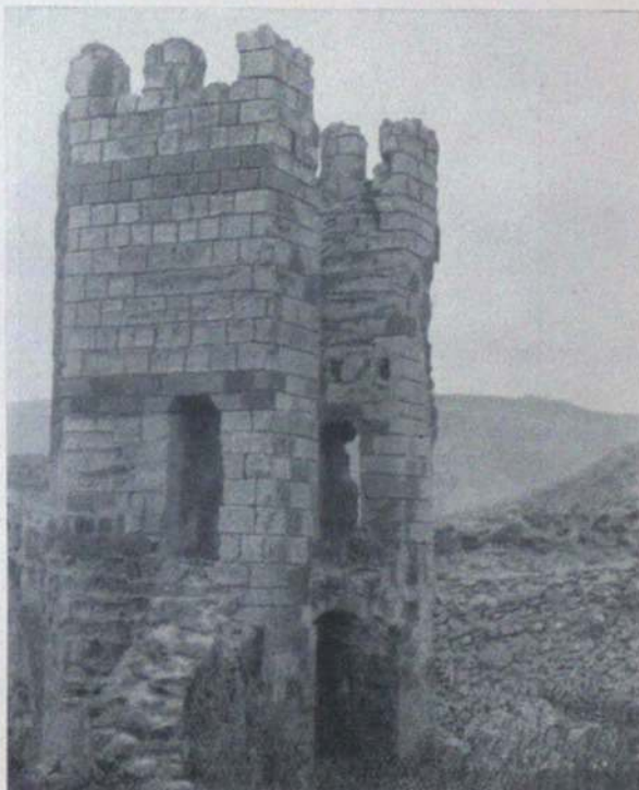
FIG. 9 - BOSA - CASTELLO DI SERRAVALLE UNA DELLE TORRI IN RESTAURO
