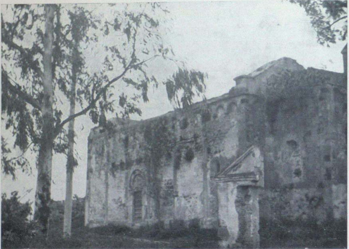
FIG. 6 - SILÌ PRESSO ORISTANO, SANTA MARIA MADDALENA - FIANCO PRIMA DEL RESTAURO
