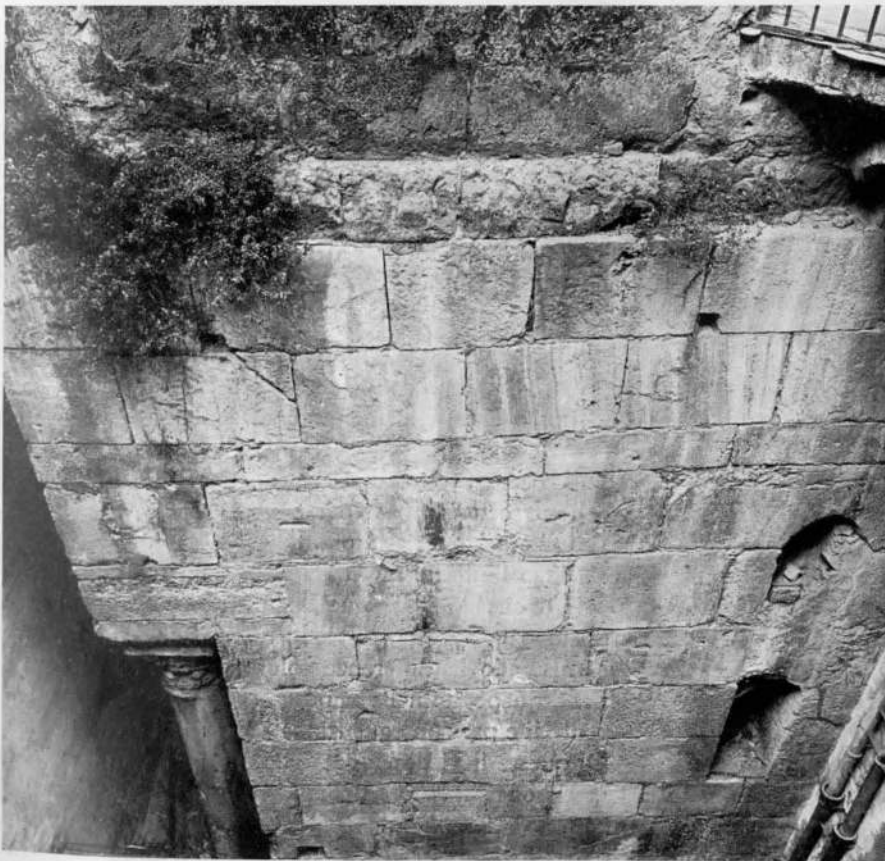
FIG. 2 - NOLA, CAMPANILE DELLA CATTEDRALE - PIANO INFERIORE
