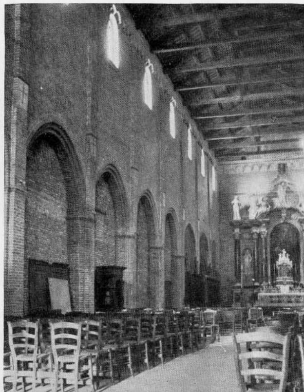
FIG. 16 - PADOVA, CHIESA DI S. BENEDETTO - INTERNO DOPO IL RESTAURO
