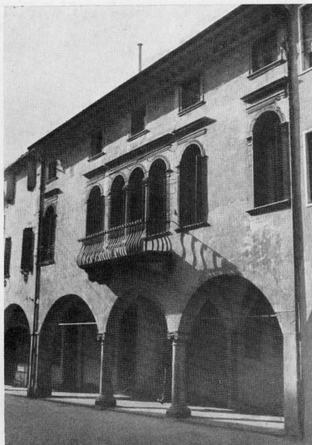
FIG. 24 - PADOVA, CASA TOLOMEI DOPO IL RESTAURO
