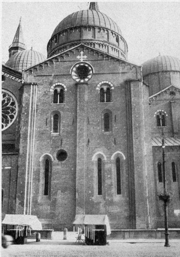
FIG. 20 - PADOVA, BASILICA DEL SANTO - IL FIANCO DOPO IL RESTAURO
