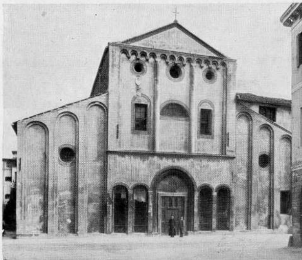
FIG. 8 - PADOVA, CHIESA DI S. SOFIA - PRIMA DEL RESTAURO
