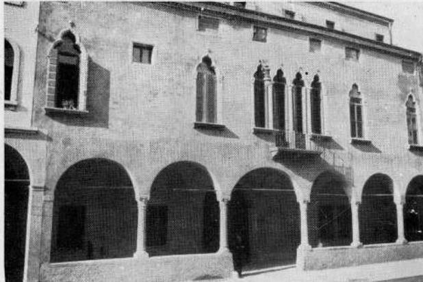
FIG. 26 - PADOVA, CASA LOCATELLI DOPO IL RESTAURO
