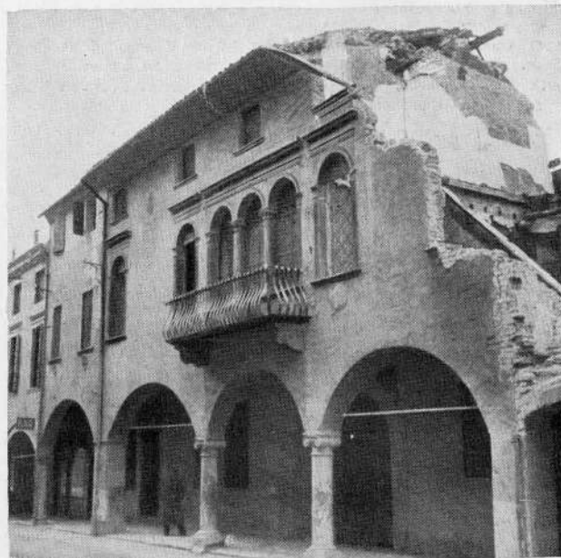
FIG. 22 - PADOVA, CASA TOLOMEI IN VIA DEL SANTO PRIMA DEL RESTAURO
