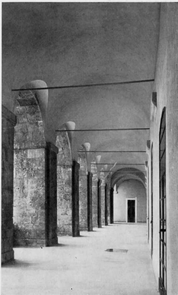
FIG. 8 - LOGGIATO AL PRIMO PIANO (Fot. Sopr. L'Aquila)
