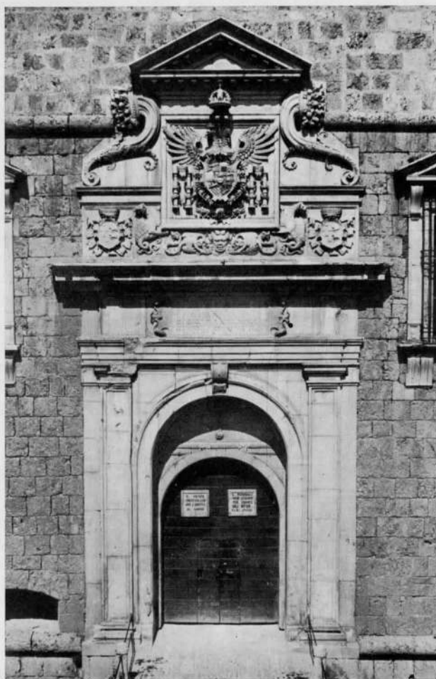
FIG. I - PORTALE PRINCIPALE (Fot. Sopr. L'Aquila)
