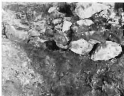
FIG. 25 — FESTÒS, VANO XXVIII L'ANGOLO SUPERIORE SUD-OVEST DELL'AMBIENTE DELLA PRIMA FASE (Si nota l'arrotondamento dell'intonaco coprente lo spigolo, e sopra il foro di un travicello obliquo)
