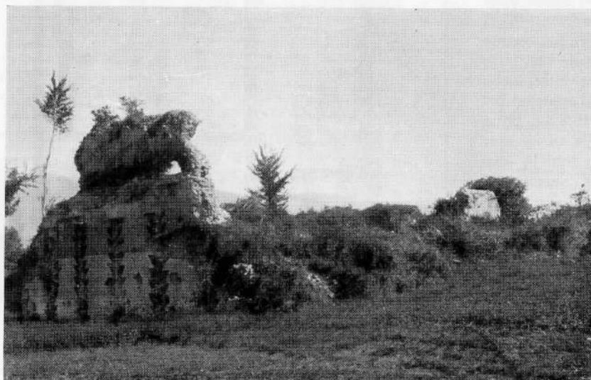
FIG. 5 - CAES, TERME CENTRALI - DA OVEST, NEL 1930
