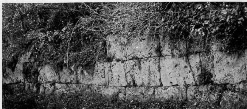
FIG. 2 - CALES, TRATTO DELLE FORTIFICAZIONI SUL LATO EST
