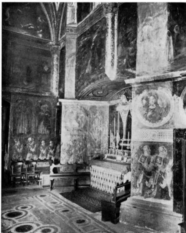
FIG. 2 - NAPOLI, DUOMO - CAPPELLA MINUTOLO: LATO SINISTRO (prima del restauro, con l'altare laterale ora rimosso)
