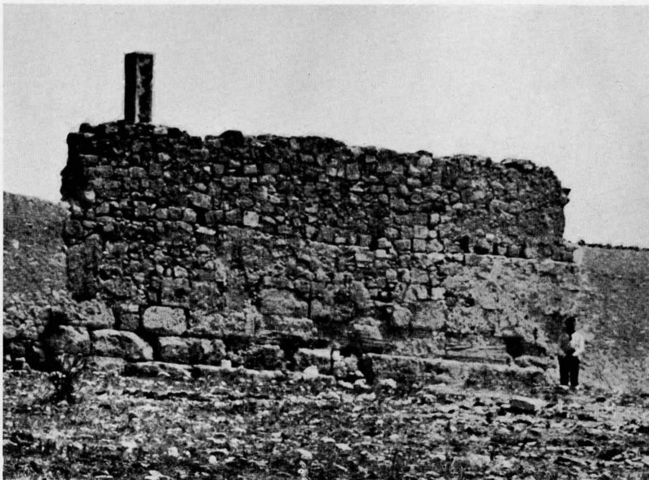
FIG. 2 - CAMARINA, TEMPIO - I RESTI DEL MURO SUD INSERITI IN UN MURO MODERNO, IN UNA FOTOGRAFIA DEL 1903 (DA NORD)
