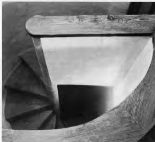
FIG. 8 - FIRENZE, CASA BUONARROTI - PARTICOLARE DELLA SCALA A CHIOCCIOLA (DOPO IL RESTAURO)
