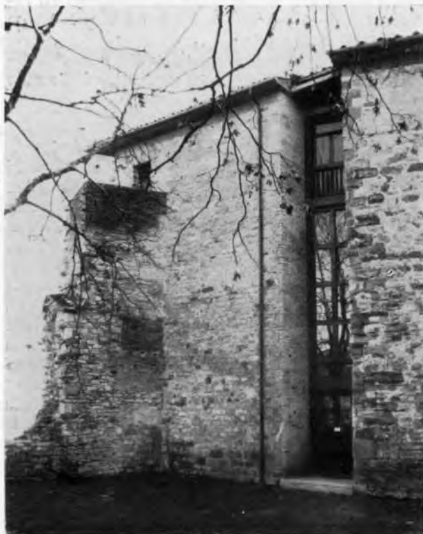
FIG. 3 - CAPRESE MICHELANGIOLO, PALAZZO DEL PODESTÀ (DOPO IL RESTAURO) - È VISIBILE IL TAGLIO REALIZZATO NELLA STRUTTURA OTTOCENTESCA PER ISOLARE LA COSTRUZIONE ORIGINARIA TRECENTESCA
