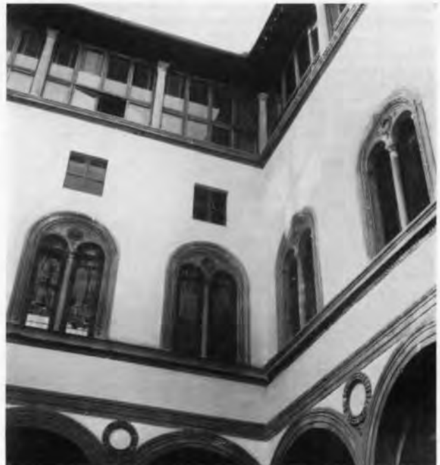
FIGG. 16, 17 - FIRENZE, PALAZZO PAZZI - IL CORTILE (PRIMA E DOPO IL RESTAURO) - IN ALTO, LA LOGGIA LIBERATA DALLE MURATURE DI TAMPONAMENTO
