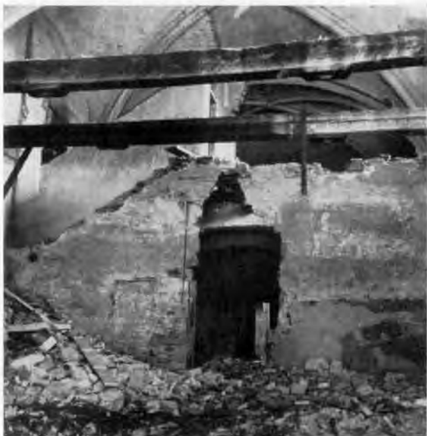
FIG. 22 - FIRENZE, CERTOSA DEL GALLUZZO - INIZIO DEI LAVORI DI LIBERAZIONE DELLE STRUTTURE SETTE-OTTOCENTESCHE
