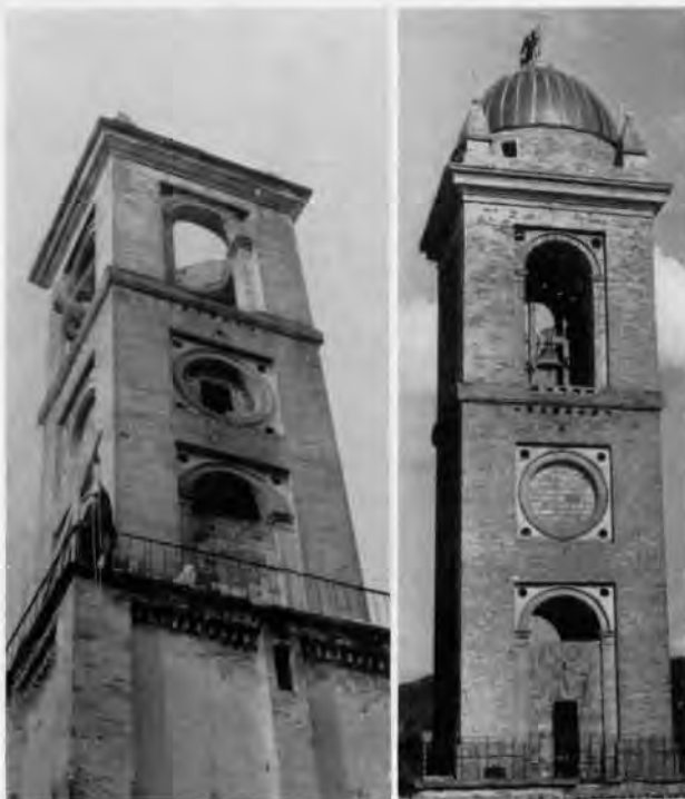
FIGG. 17, 18 - PIANDIMELETO, S. AGOSTINO - IL CAMPANILE (PRIMA E DOPO IL RESTAURO)
