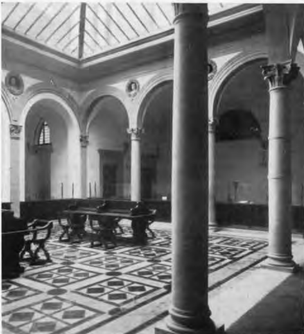
FIGG. 16, 17 - FIRENZE, PALAZZO PAZZI - IL CORTILE (PRIMA E DOPO IL RESTAURO) - IN ALTO, LA LOGGIA LIBERATA DALLE MURATURE DI TAMPONAMENTO
