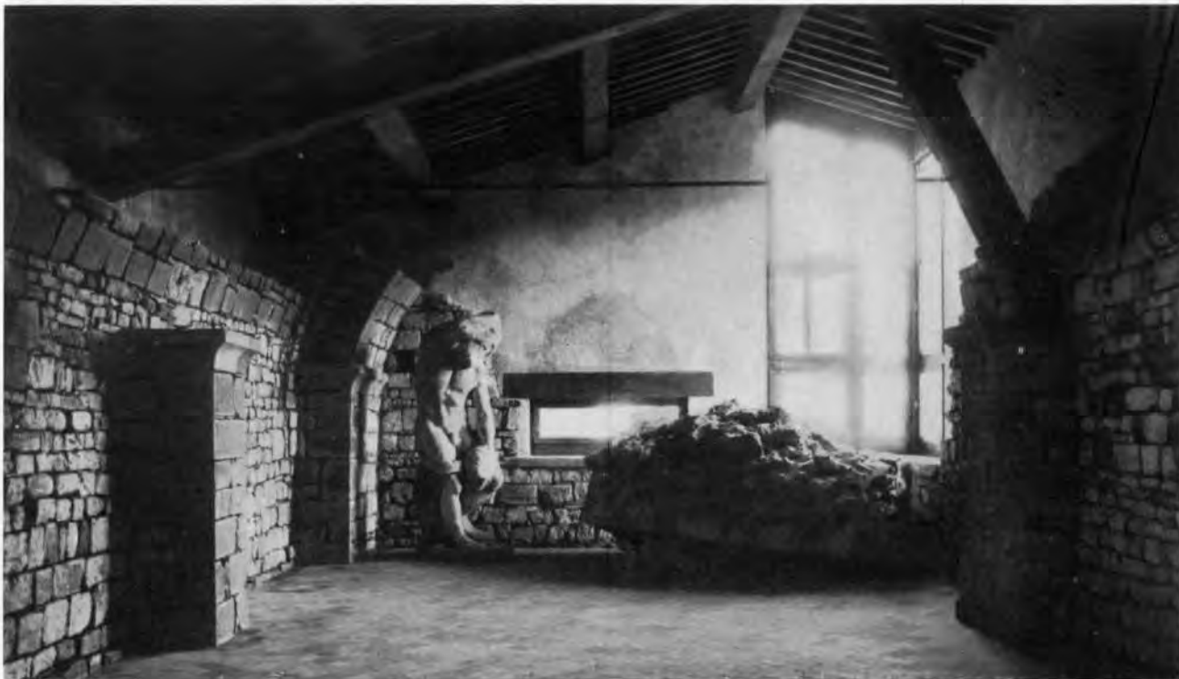
FIG. 2 - CAPRESE MICHELANGIOLO, CASTELLO - LA SALA DEL MASTIO (DOPO IL RESTAURO)
