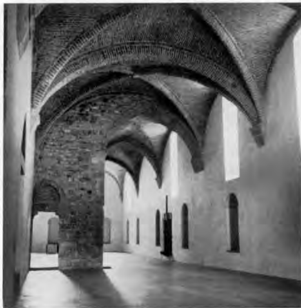
FIG. 23 - FIRENZE, CERTOSA DEL GALLUZZO - RIPRISTINO DELLE STRUTTURE TRECENTESCHE
