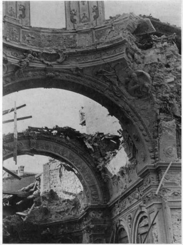
FIG. 5 - BRESCIA, S. MARIA DEI MIRACOLI - L'INTERNO DELLA CHIESA DOPO IL BOMBARDAMENTO
