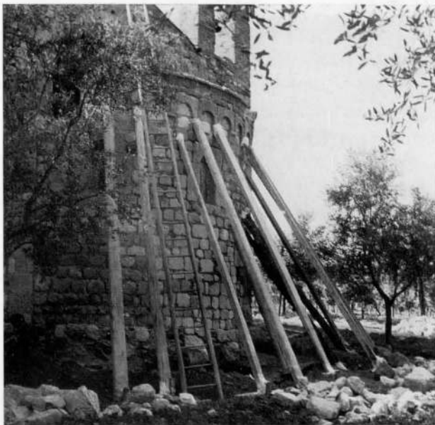
FIGG. 30, 31 - PADENGHE, S. EMILIANO - DELL'ABSIDE DURANTE IL CONSOLIDAMENTO E A RESTAURO ULTIMATO
